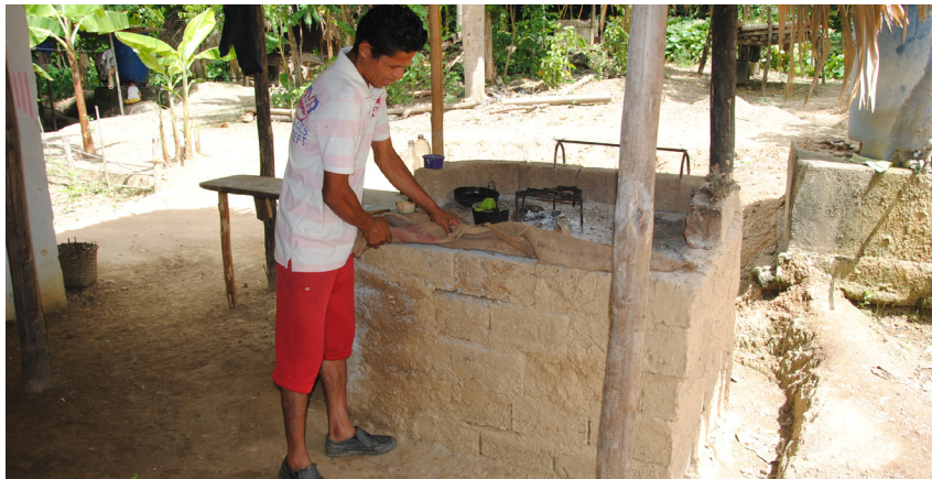
Bloques de adobe realizados en la comunidad
