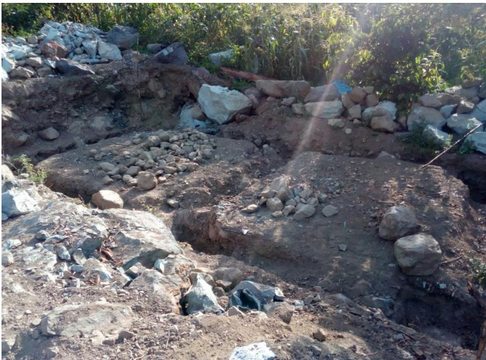
Foto 12 - Excavacion de zanja para vivienda
