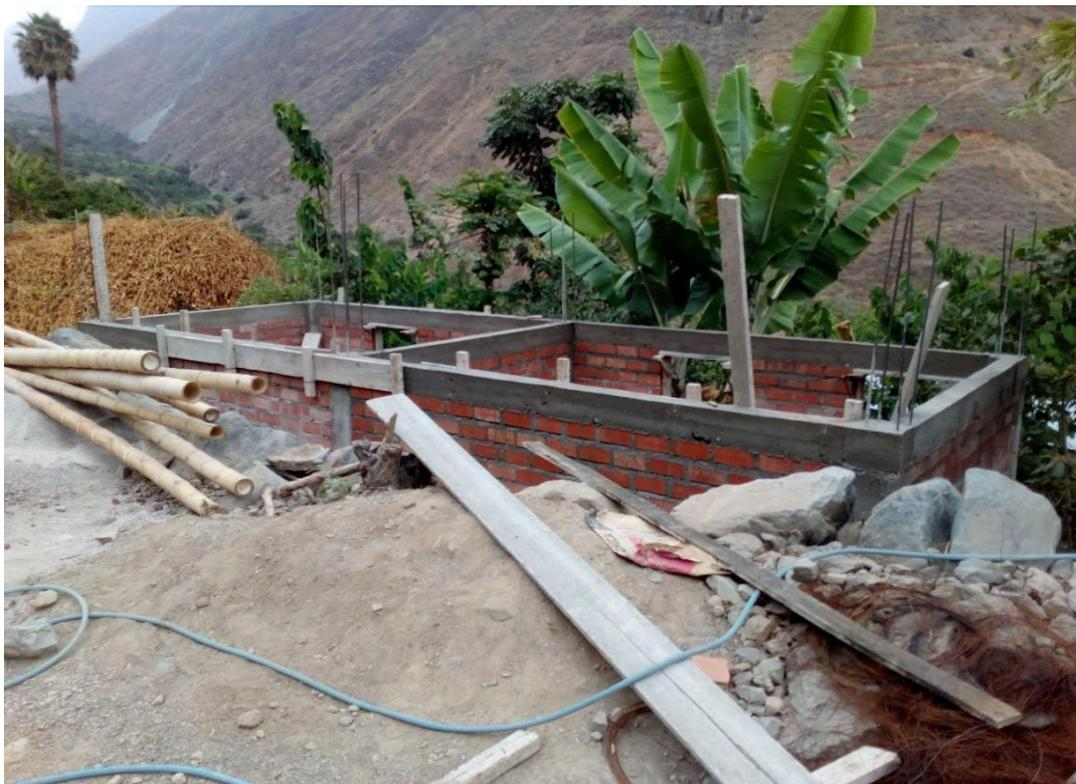
Foto 37 - Desencofrado de collarin
