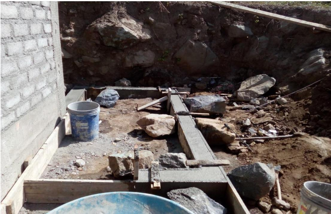
Foto 6 -Vaciado de concreto al sobrecimiento del baño
