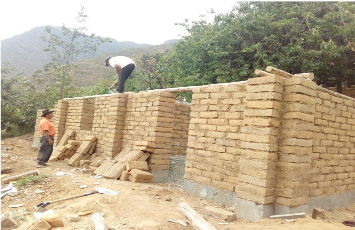
Foto 26 - Colocación de eucaliptos para el collarin
