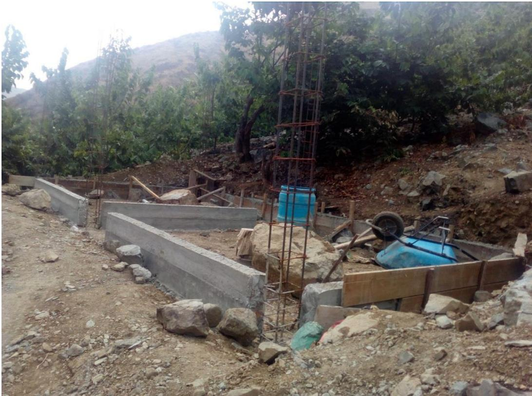
Foto 43 - Desencofrado de cobrecimiento
