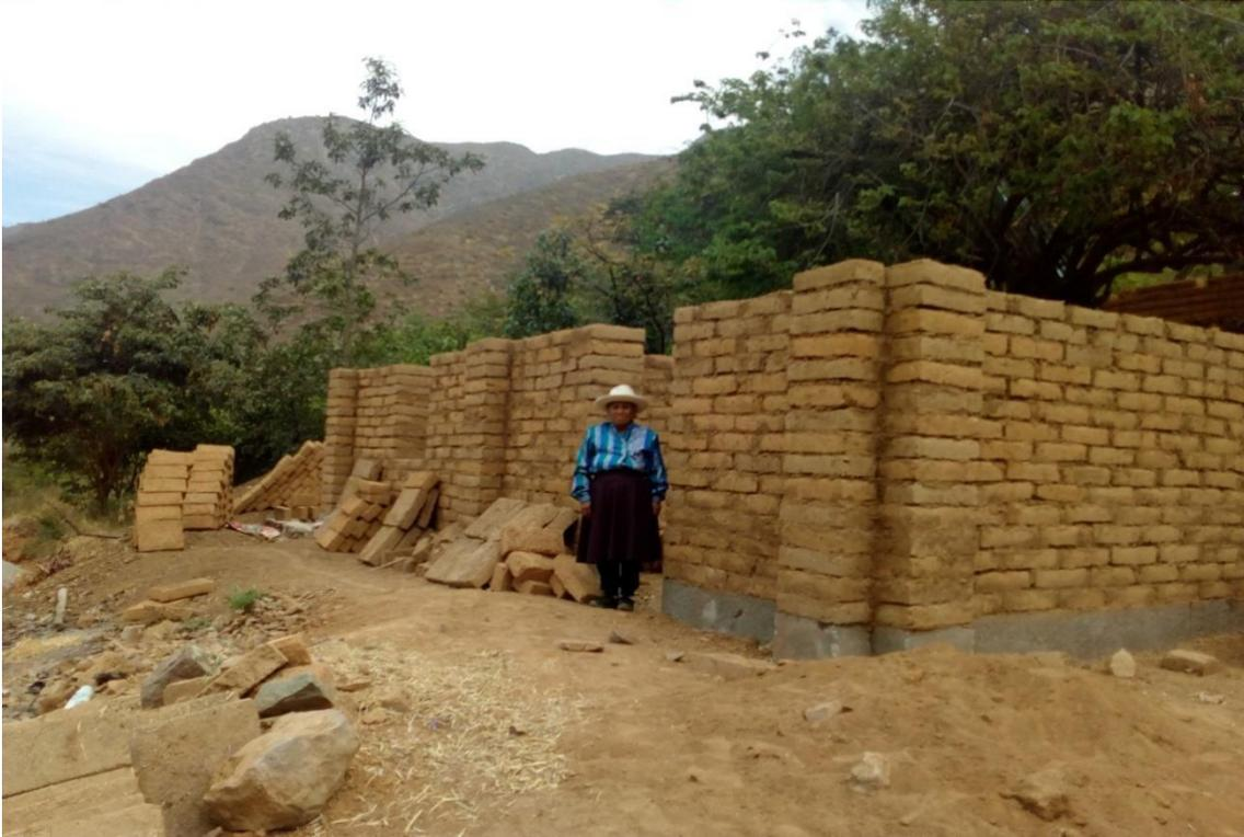
Foto 23 - Construcción de muros de adobe – altura 2 metros
