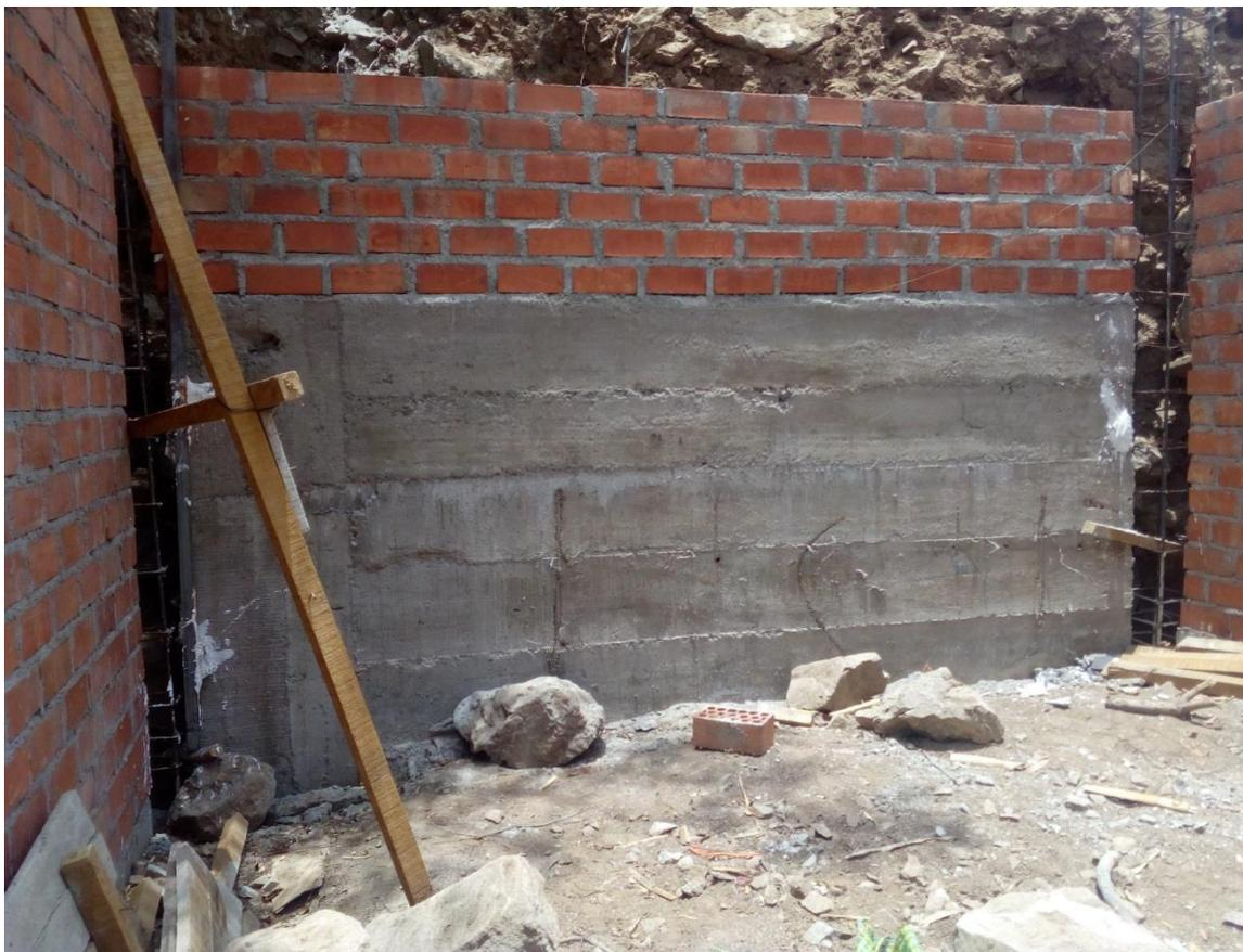
Foto 18 - Placa de cemento para evitar daños por deslizamiento
