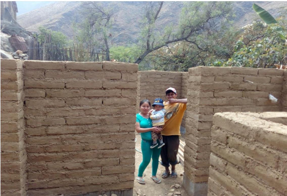
Foto 20 - Construcción de muros de adobe – altura 2 metros
