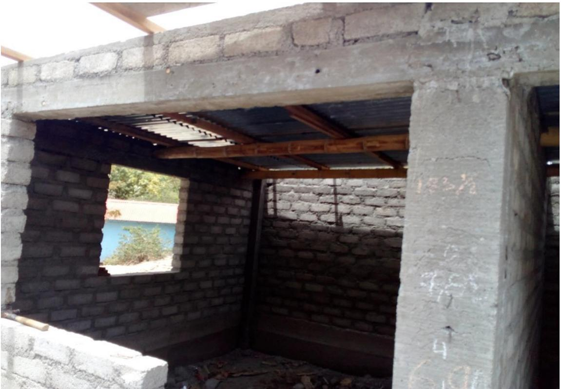
Foto 10 - Colocando calaminas para techo
