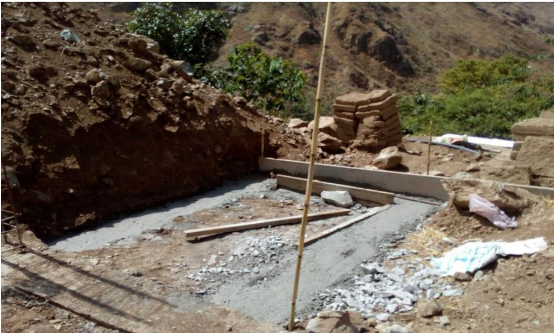
Foto 40 - Vaciado de concreto al cimiento del baño
