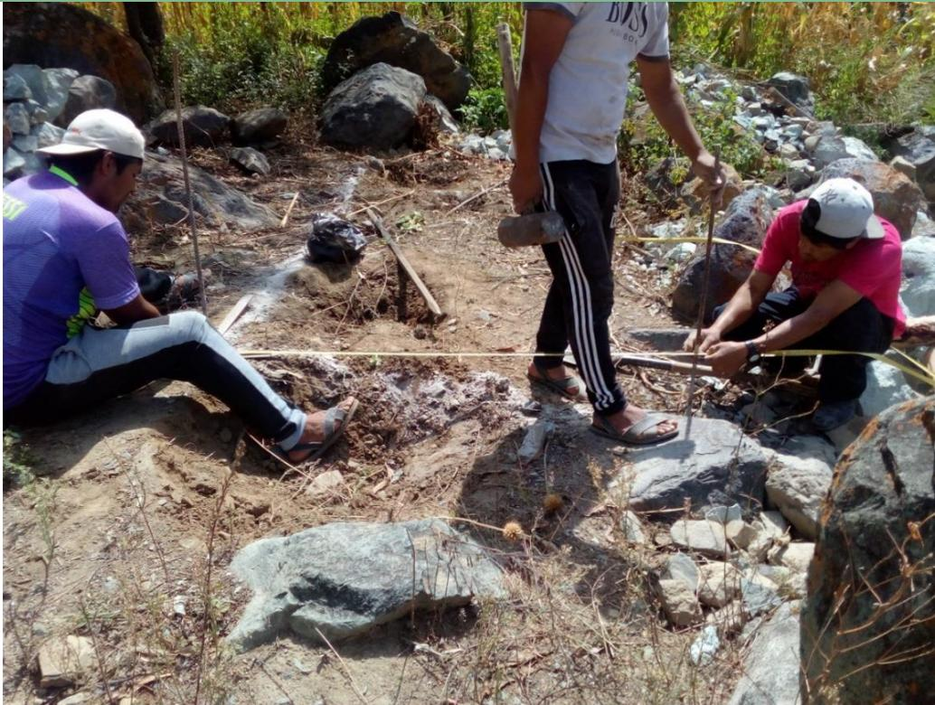
Foto 11 - Trazo, nivelación y replanteo del baño
