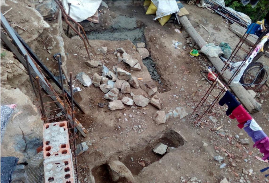
Foto 15 - Vaciado de concreto a la base del baño
