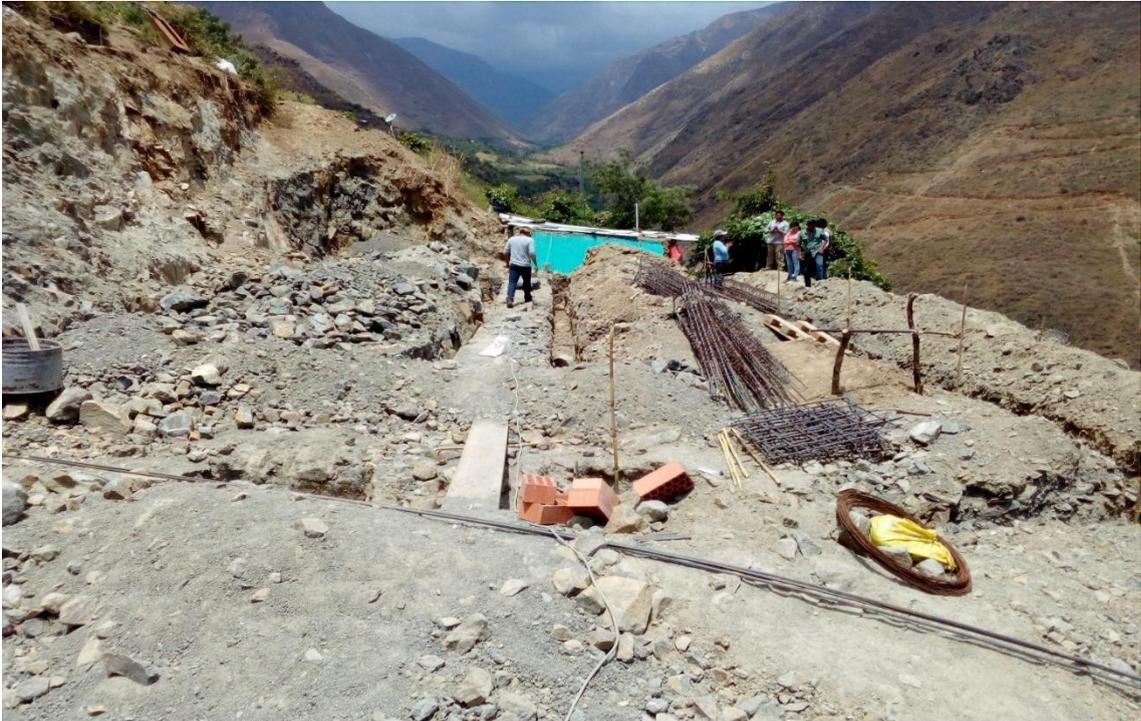
Foto 31- Trazo, replanteo y zanja para construcción de vivienda
