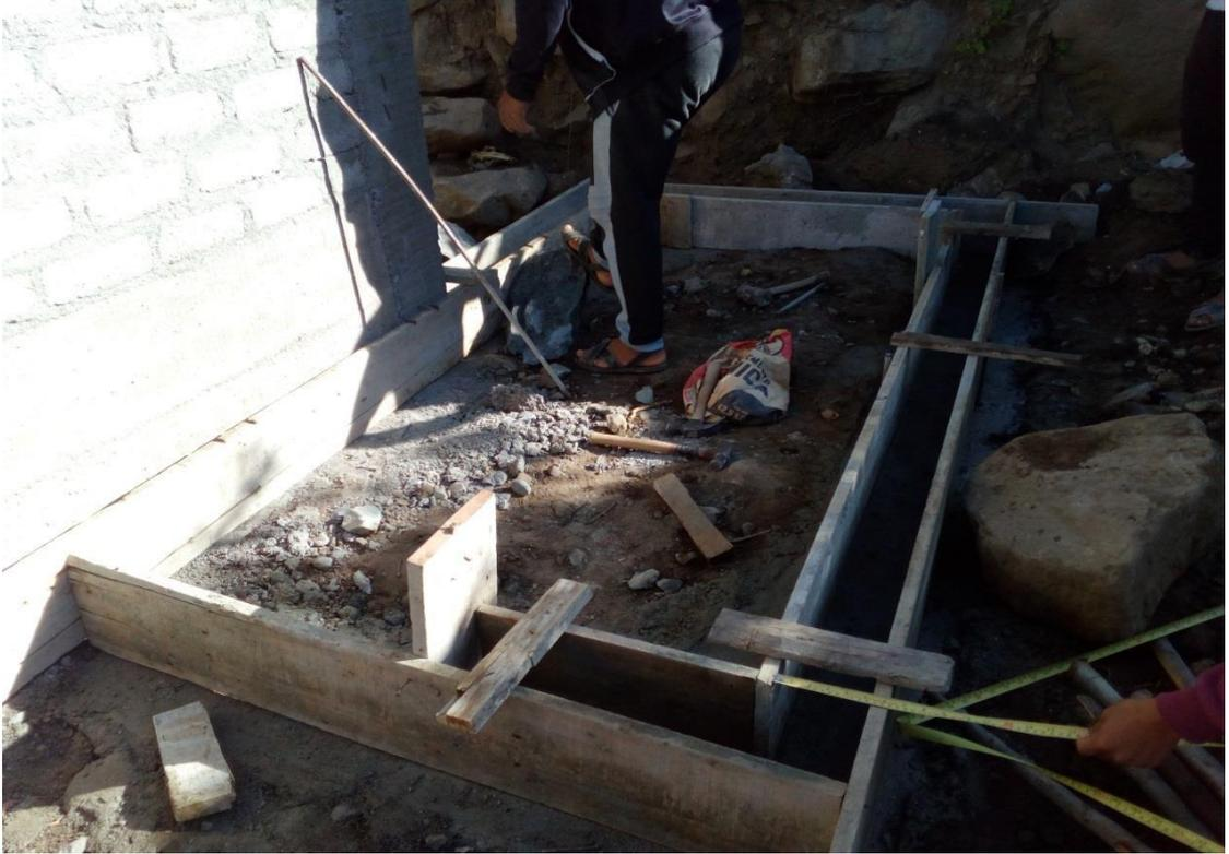
Foto 5 - Encofrado de sobrecimiento del baño
