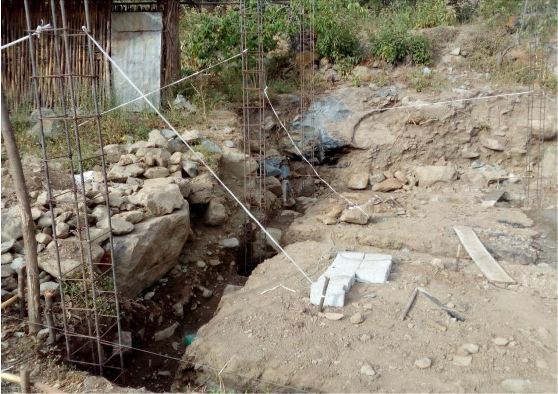
Foto 7 - Instalación de columnas
