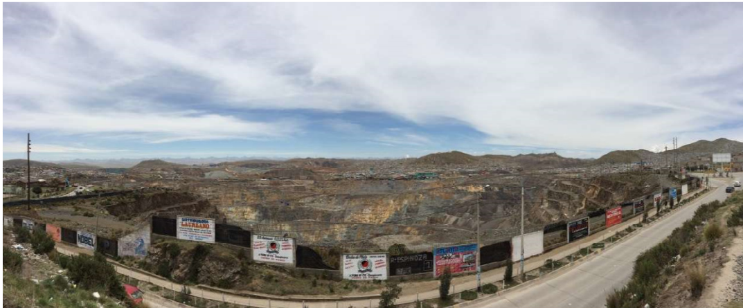
Bild 1: die offene Minengrube “Raúl Rojas” mit einem Durchmesser von 4,4km; im Hintergrund sind die Schuttberge der Minen sowie nahe gelegene Wohnhäuser zu sehen.
