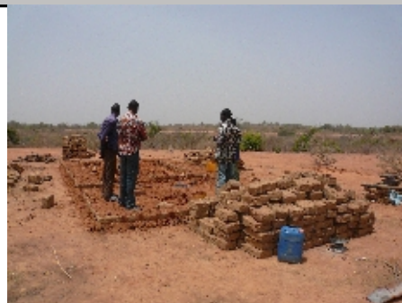
Maison en chantier
