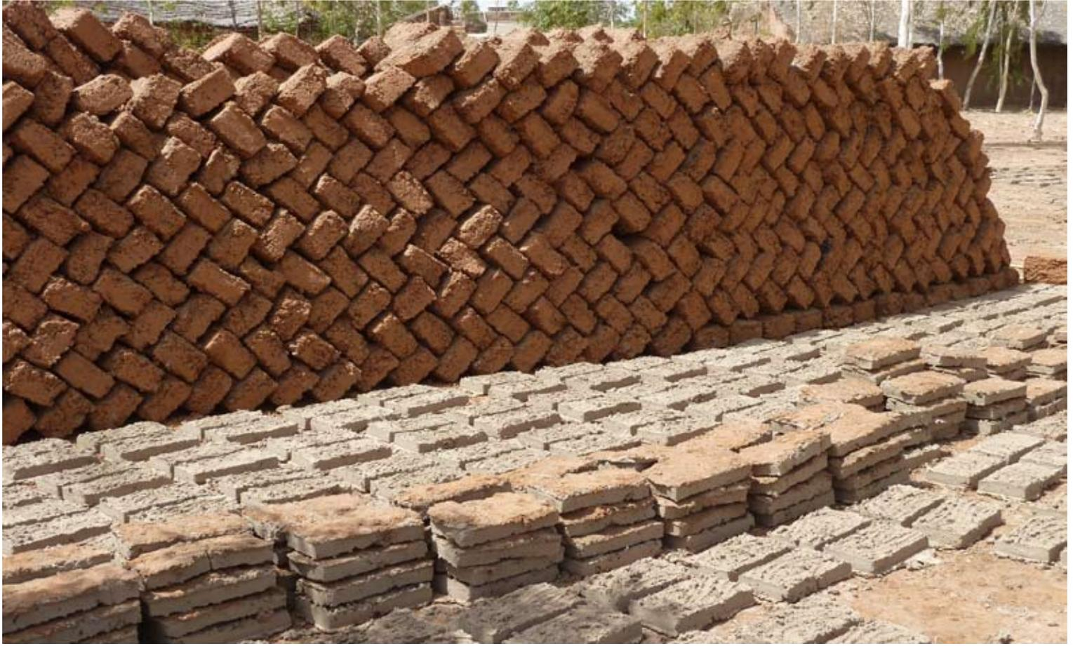
la construction a nécessité des dizaines de milliers de briques de banco pour les élévations et de briquettes d'argile pour les voutes.
